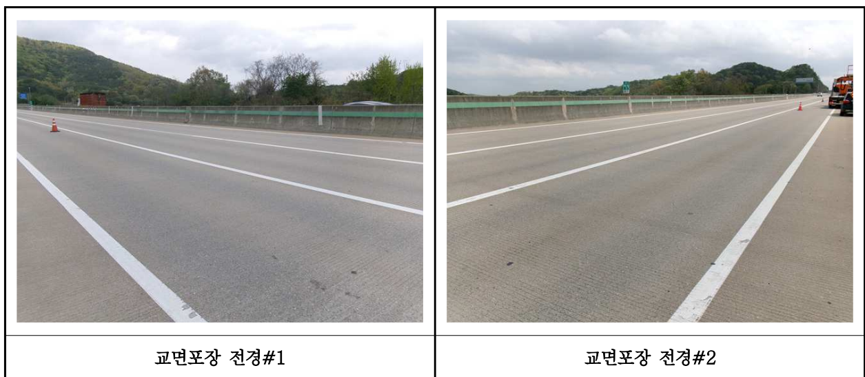
【사진 25.3.20】 교면포장 전경
