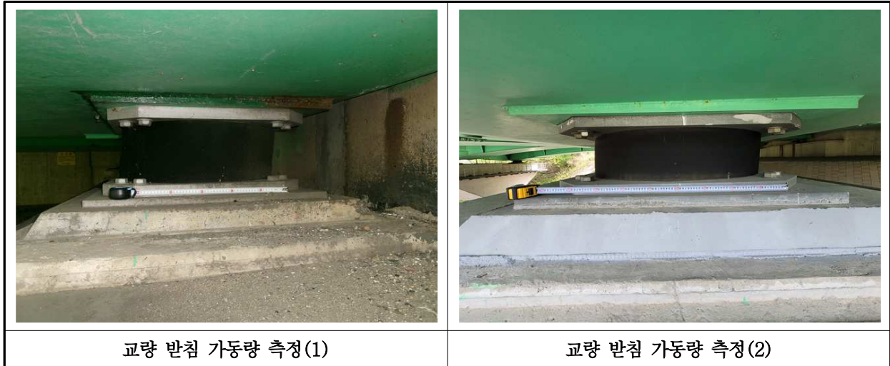
【사진 25.3.16】 교량받침 이동량 측정
