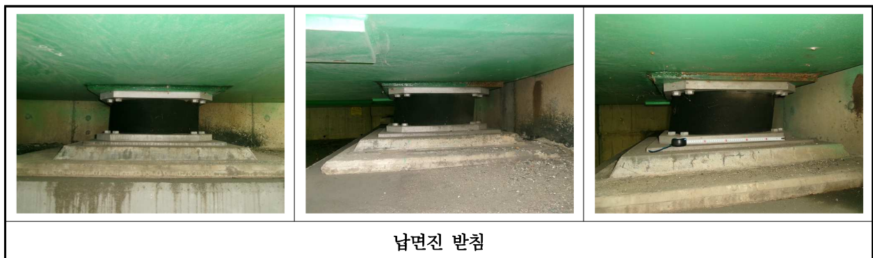
【사진 25.3.13】 교량받침 전경
