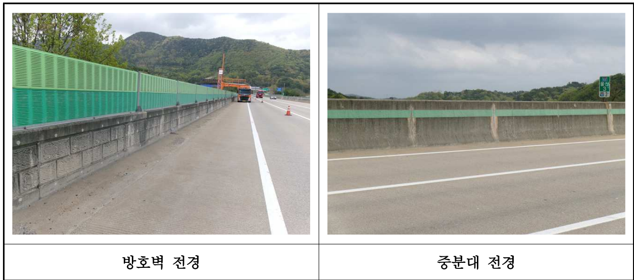
【사진 25.3.24】 방호벽 및 중분대 전경
