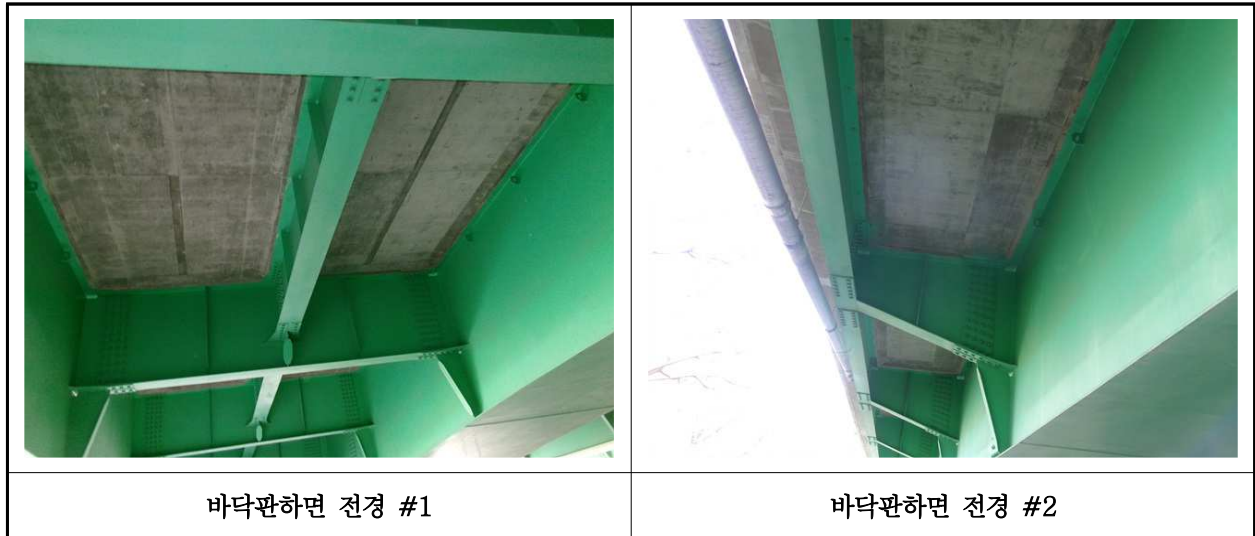
【사진 25.3.2】 바닥판하면 전경
