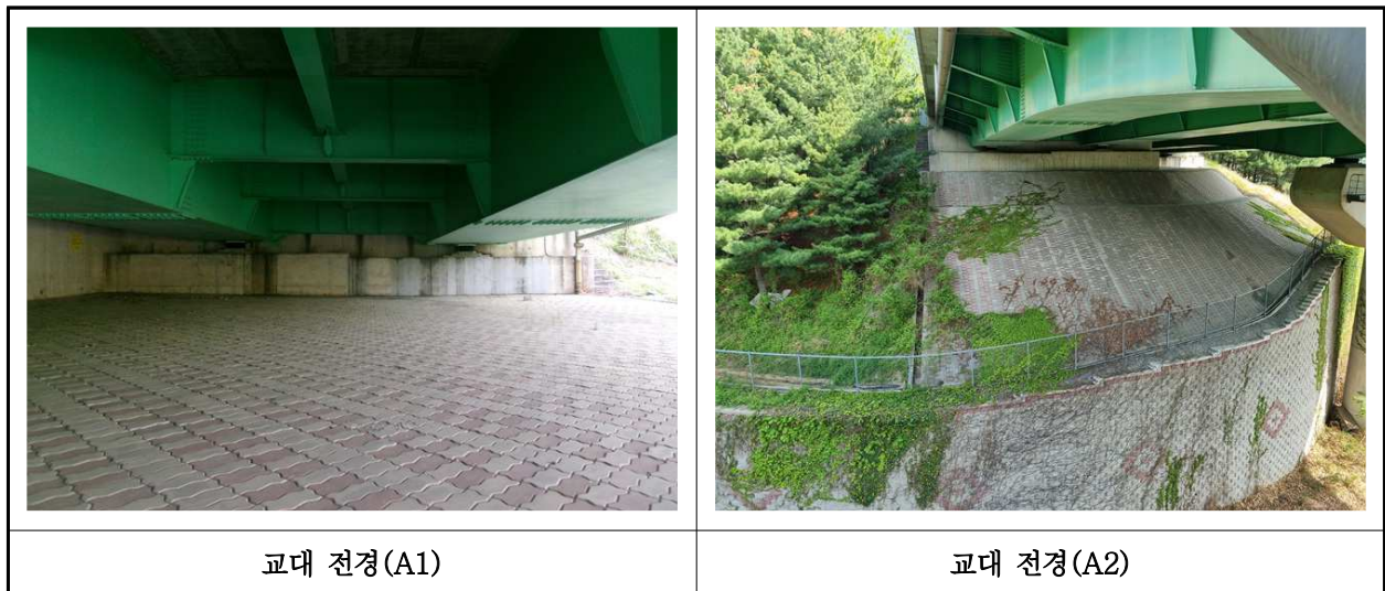
【사진 25.3.8】 교대 전경
