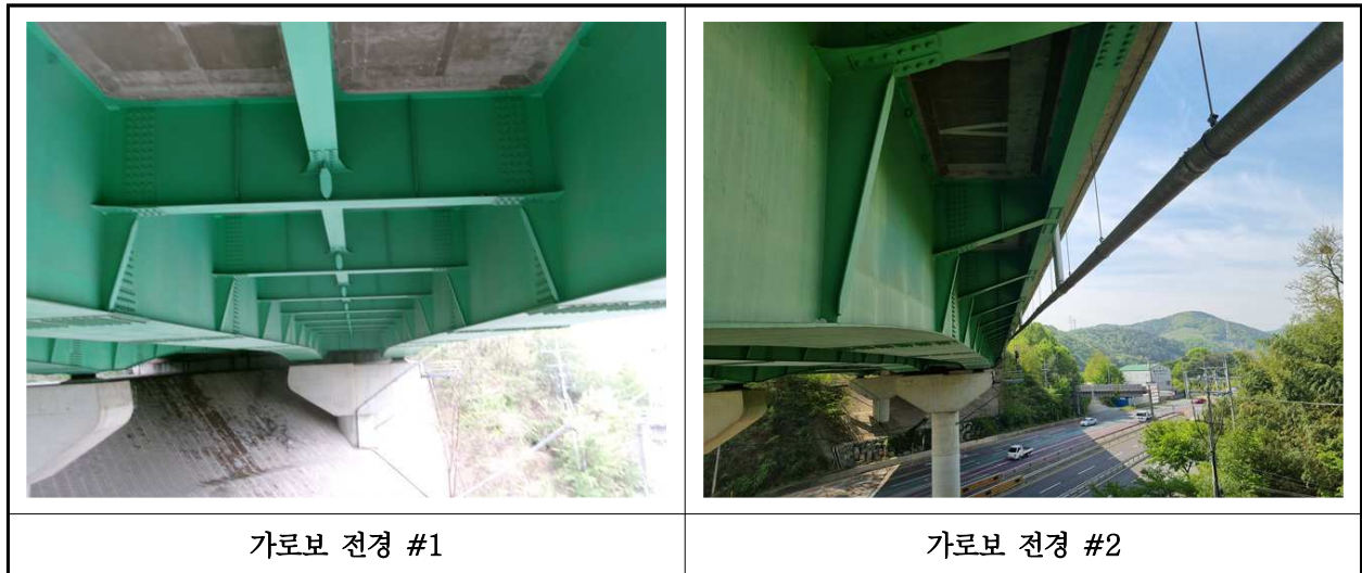
【사진 25.3.6】 가로보 전경
