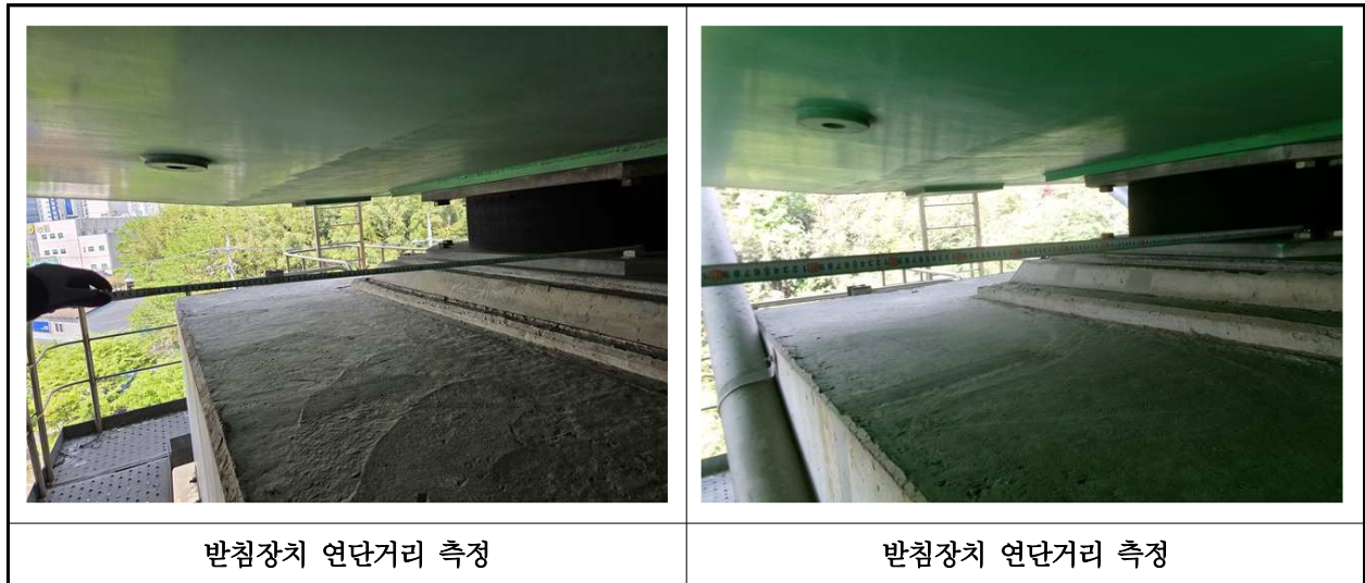
【사진 25.3.15】 교량받침장치 연단거리측정
