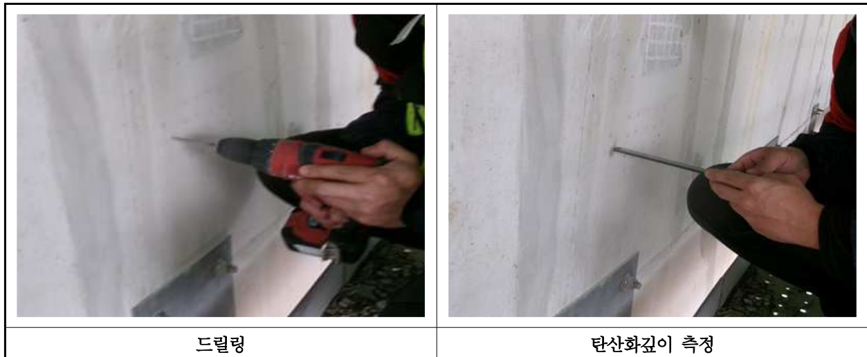
【사진 25.4.3】 탄산화 깊이 측정 현장사진
