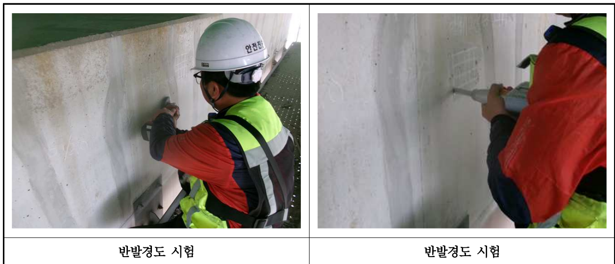
【사진 25.4.2】 반발경도시험 현장사진
